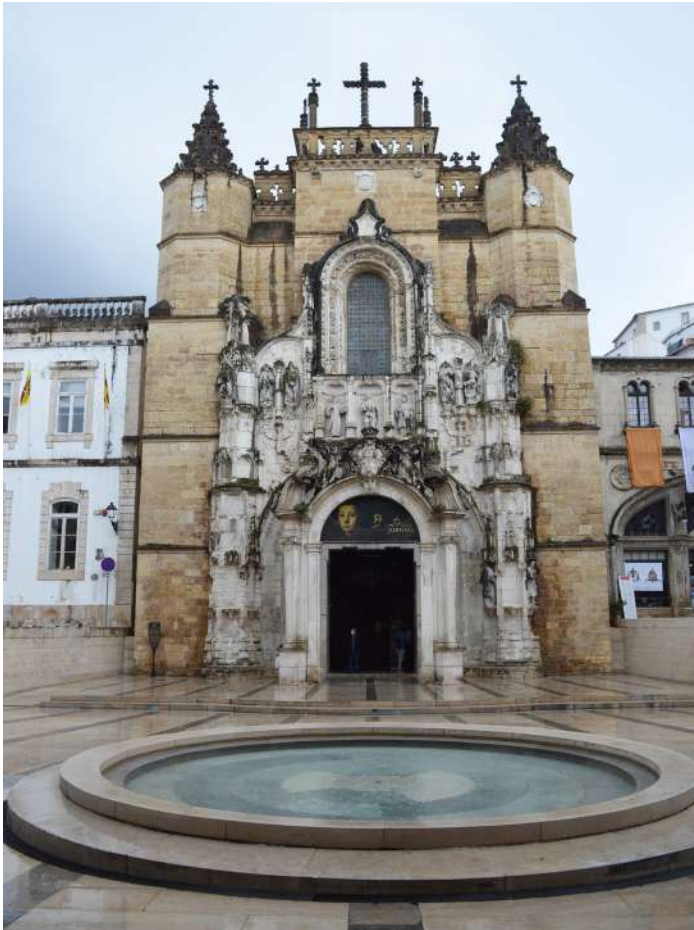
Figura 6 - Praça 8 de Maio (Fernando Távora, 2003). Fotografia do autor.
